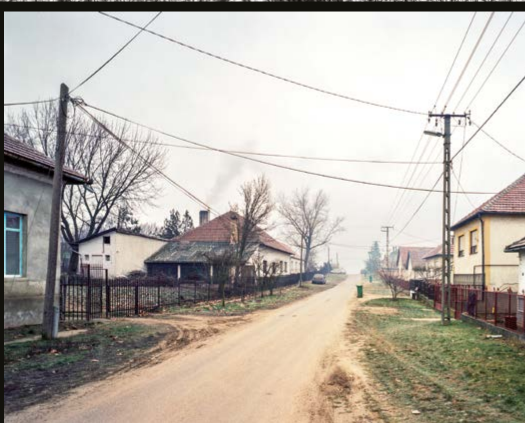
Tiszaeszlár Újfalu (die neuere Siedlung), Januar 2016
